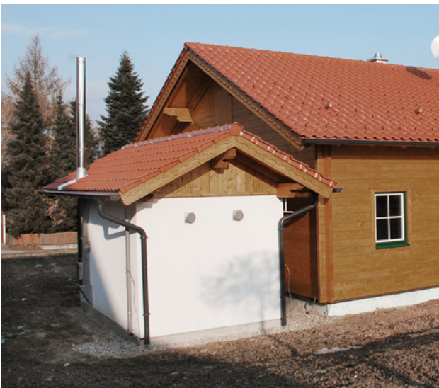
Einfamilienhaus in Weng i. L., 12 kW Pellets
