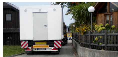
Lieferung der Heizmodule mit Tiefloader
