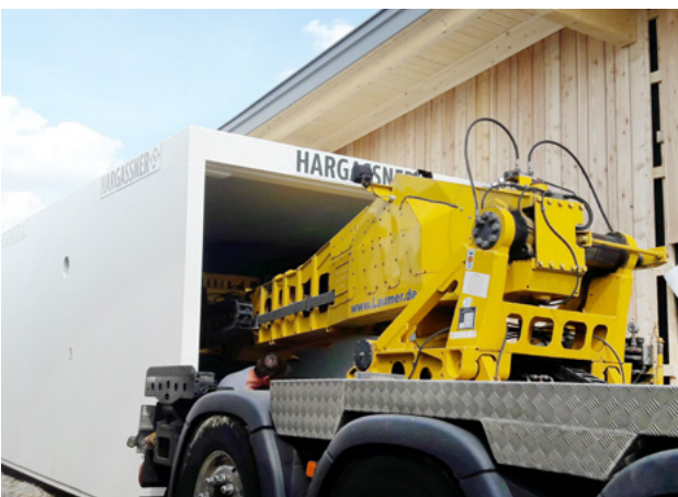
Lieferung der Heizmodule mit Tieflader
