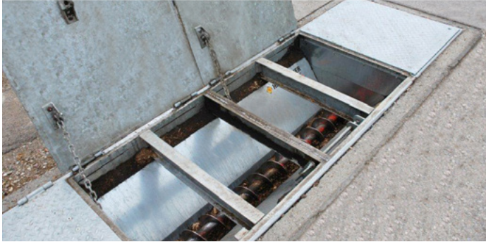
Befahrbare Variante einer Befülltragabdeckung an der NMS in Eggelsberg
