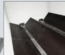
Pelletslager im OG 2 Raumaustragungs- schnecken inkl. Schrägboden
