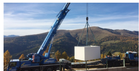
Versetzen mit Autokran
