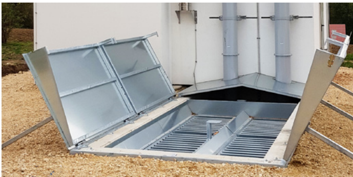
Befüllgasse mit doppeltem Befüllsystem für stirnseitige Beschickung in NÖ
