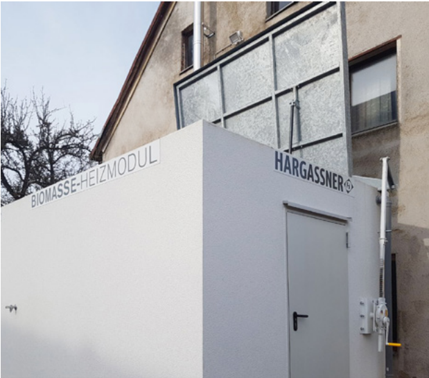
Fahrnbauer in Eschenbach, 35 kW Hackgut
