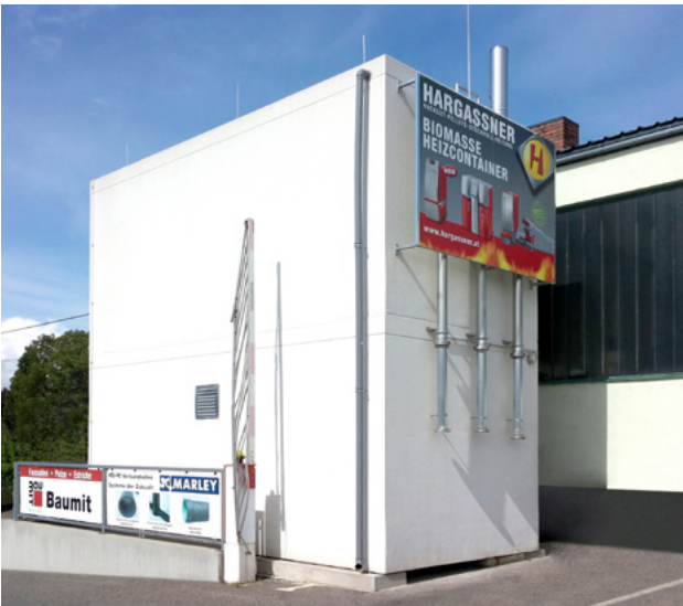
Lagerhaus in Neuhofen, 2 x 90 kW Pellets
