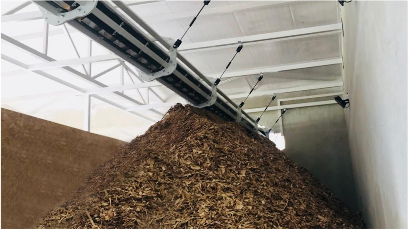
Il est possible de remplir le silo via une vis de remplissage et une vis verticale. Une ou plusieurs vis horizontales assurent un remplissage complet et une répartition homogène du bois déchiqueté dans le silo.
