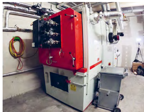
Zufrieden Ein 550 kW starker Pelletkessel sorgt in Kombination mit einem 10.000 Liter großen Pufferspeicher für umweltfreundliche Wärme im Hotel.
