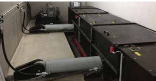
Vérins hydrauliques robustes pour le mouvement du fond racleur
