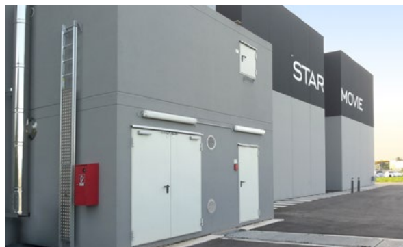
Sistema contenerizado de astillas de doble piso, 200 kW, uso empresarial
