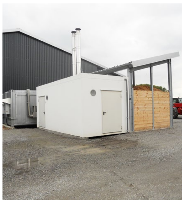
Sistema contenerizado de astillas de un piso, 2 x 100 kW, uso empresarial
