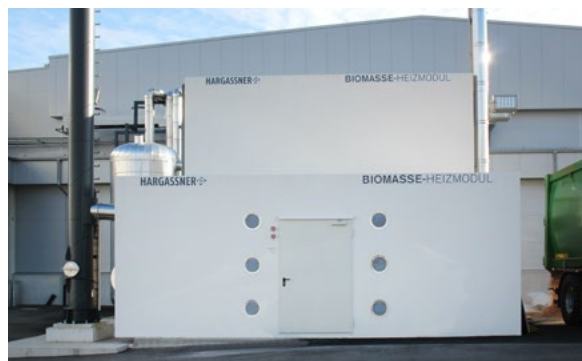
Sistema contenerizado múltiple de astillas x, 660 kW, uso industrial
