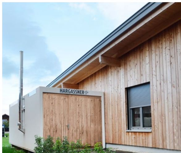
Eco-Box 20 kW de pellets, bloque de viviendas
